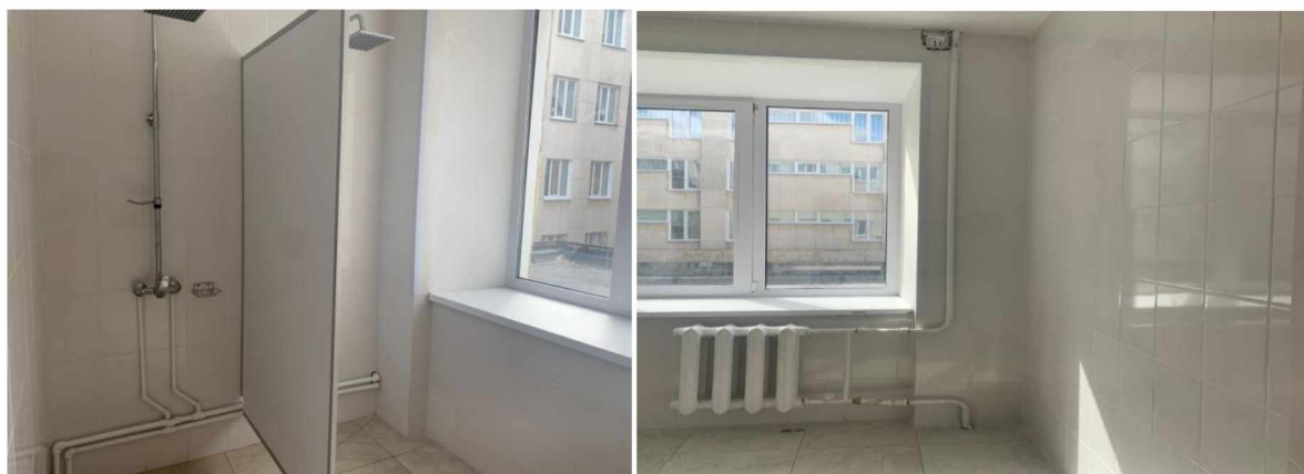
Рисунок 50. Капитальный ремонт душевых учебного корпуса №5
